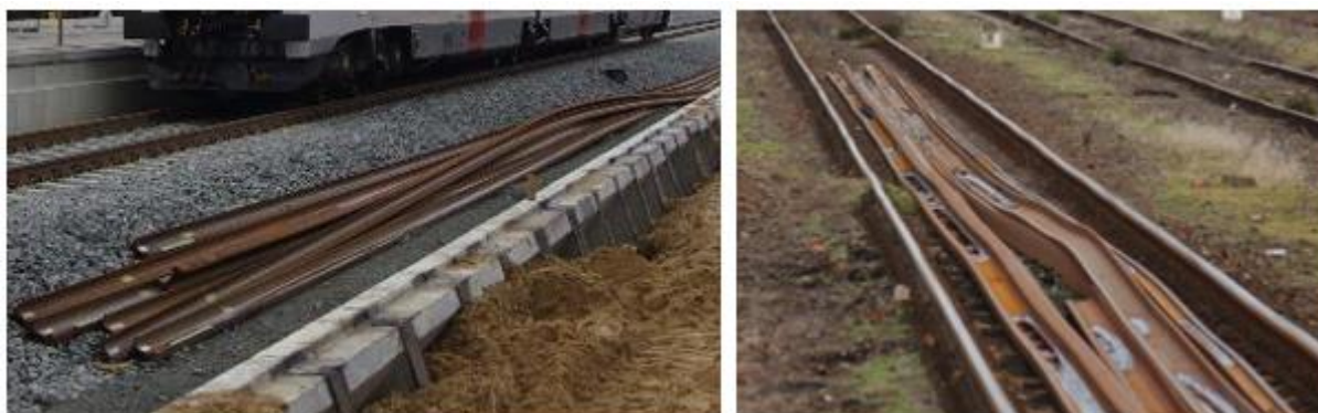
Rys. 2 Błędy w składowaniu szyn [źródło: www.skyscrapercity.com ]
